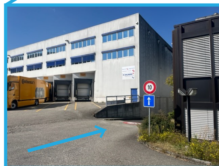
Anfahrt Rampe Unten!
